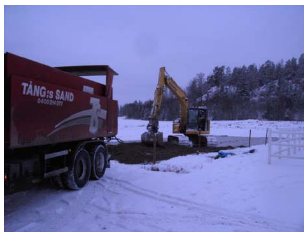
Kuva: tarhan pohjatyöt alussa
