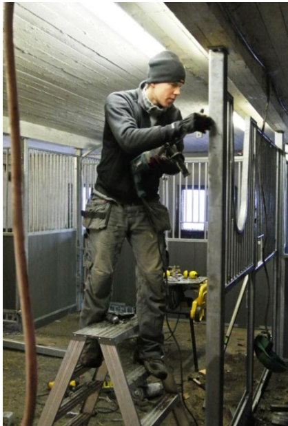
Kuva: Ison-tallin karsinaelementtien pystytystä
