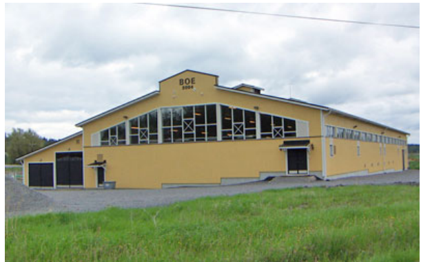
Kuva: Boen lämpöeristetty maneesi
