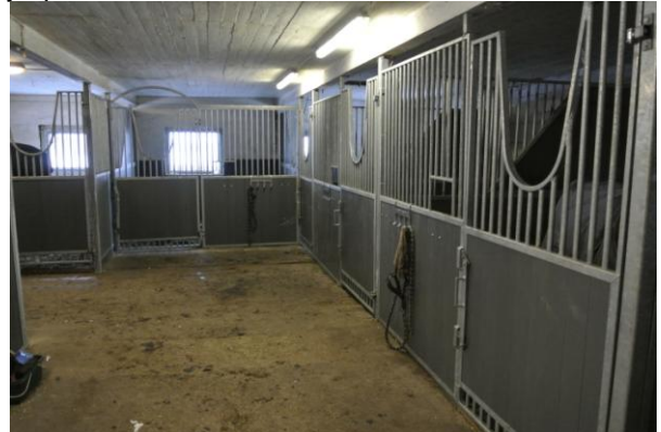
Kuva: Ison -tallin käytävää. Hevosilla ovissa U-muotoinen aukko, josta ne saavat päänsä ulos karsinasta. Oven alaosassa pieni ilmastoitu aukko, joka saa ilman kiertämään karsinassa.
