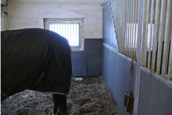
Kuva: karsinoiden väliseinät ovat osin ylös saakka ummessa, näin hevonen saa halutessaan omaa rauhaa naapurilta. Takaseinien alaosa muovilevytetty, näin se on helppo pitää puhtaana ja on siistin näköinen.
