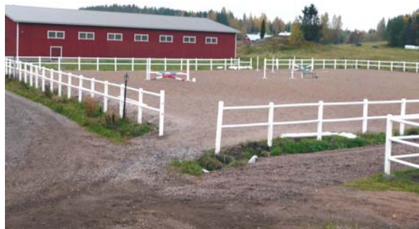
Kuva: uusi kenttä maneesin suuntaan katsottuna
