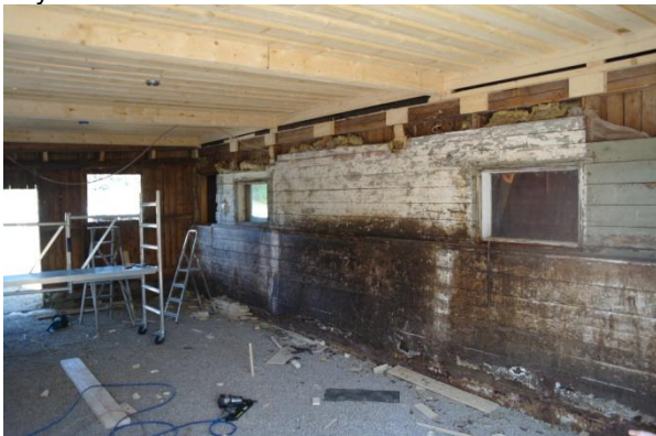
Kuva: uusi välikatto on paikallaan, lattialla sora, seinät odottavat toimenpiteitä.
