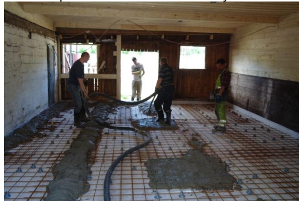
Kuva: lattian valu alkuvaiheessa
